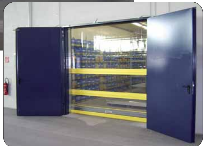
F90 Kühlager mit zusätzlichem Schnellauftor
