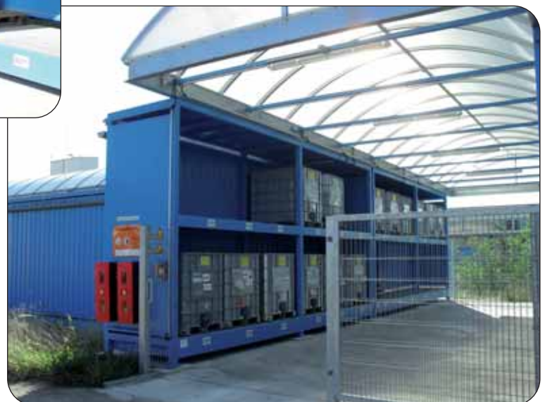
◆ Lagerbereich für IBC/KTC
